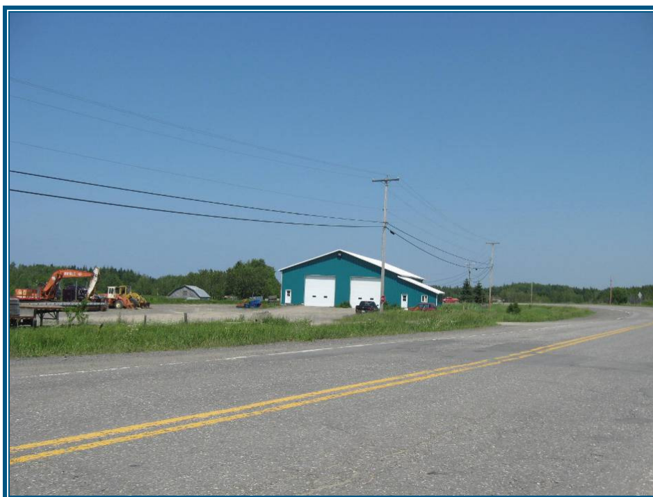
Photo 8 : Garage pour camions lourds
